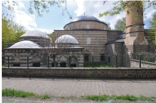
Şekil 4. İskender Paşa Cami Türbelerinin Doğu Cephesi (2021)
