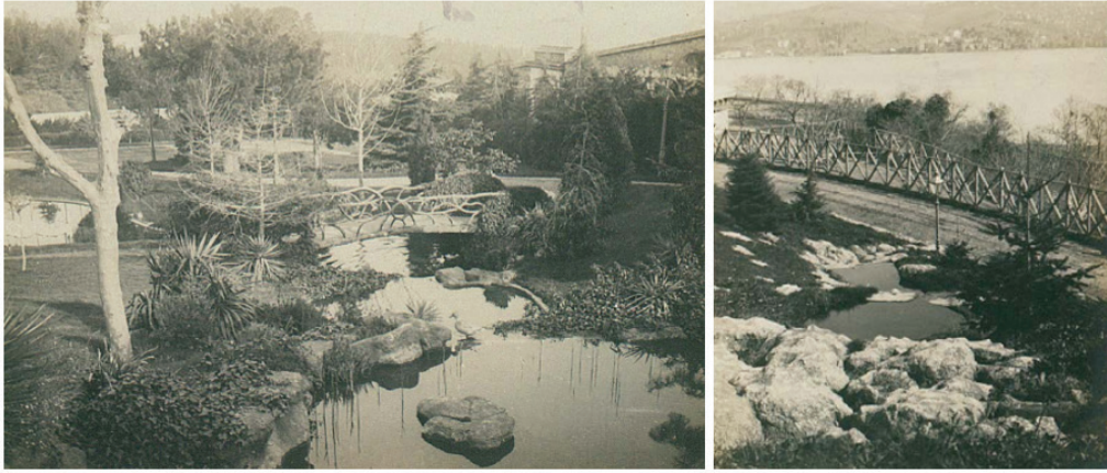
Şekil 10. Has Ağıllar Kısmında Bulunan Yapay Bir Dere Şeklindeki Su Ögesi 10
