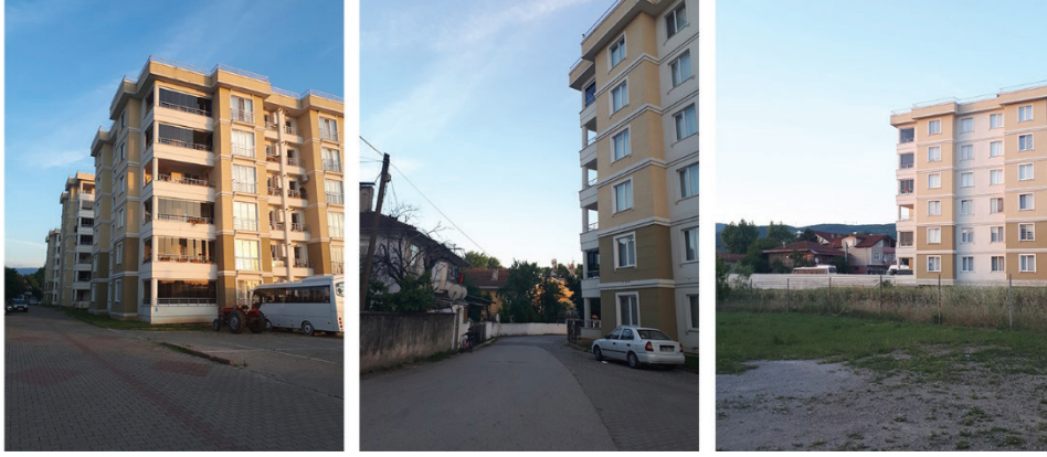
Şekil 7. Kemaliye Mahallesi Kentsel Dönüşüm Alanı Görünüm
